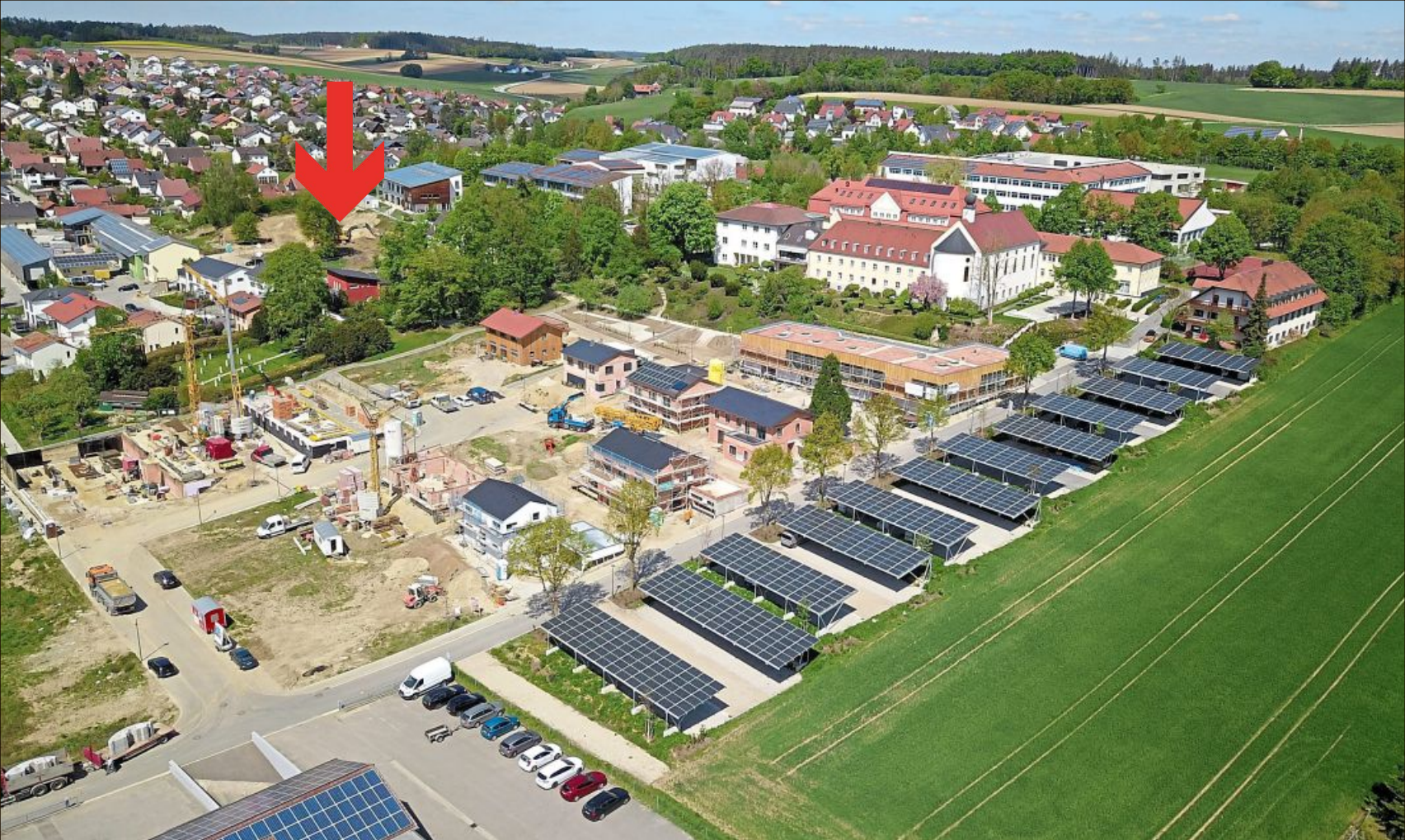
Aus der Luft sind die aktuellen Bauprojekte rund um das Maristenkloster gut zu sehen: vor dem Kloster die Schaubrauerei mit Destillation, links daneben die Einfamilienhäuser und die drei Mehrfamilienprojekte sowie im Hintergrund die Kinderhaus-Baustelle. Foto: Andreas Horsche
